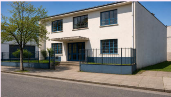
Sol, pavimento seco, limpieza y retiro del grafiti.
